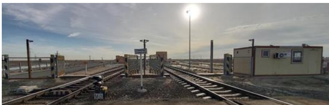
Рисунок 6 – Монтаж камер видеонаблюдения
